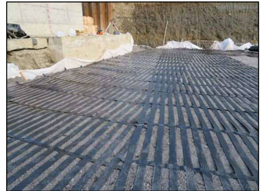
ジオシンセティックス敷設
