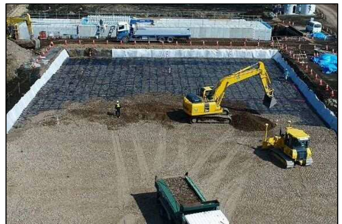
施工写真（上空より撮影）
