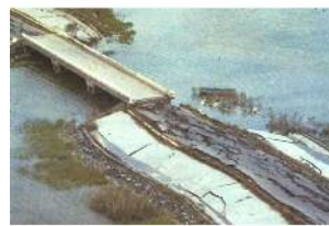
(3) 堤体の液状化による被害の事例 2011.東日本大震災
