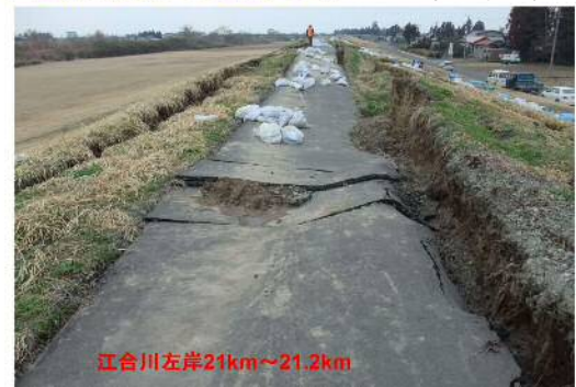
(3) 堤体の液状化による被害の事例 2011.東日本大震災
