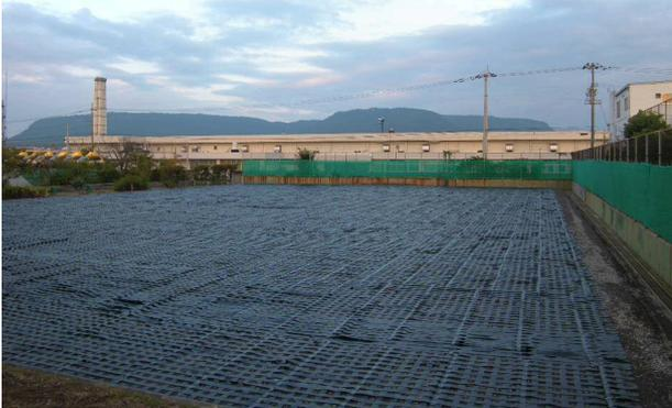
南海トラフで2mの津波高さが想定されており、津波が引いた後NEXCO緊急車両がスムーズに現場に直行する必要がある。レベル2地震動(設計水平震度0.4)にて設計し、地震後に盛土が大変形しないことが数値解析(ALID)を用いて照査された。2013年9月にSECURE-Gの初めての適用事例として施工され、今年度、同じ敷地内で、追加工事が施工され、2回目の適用事例となった。
