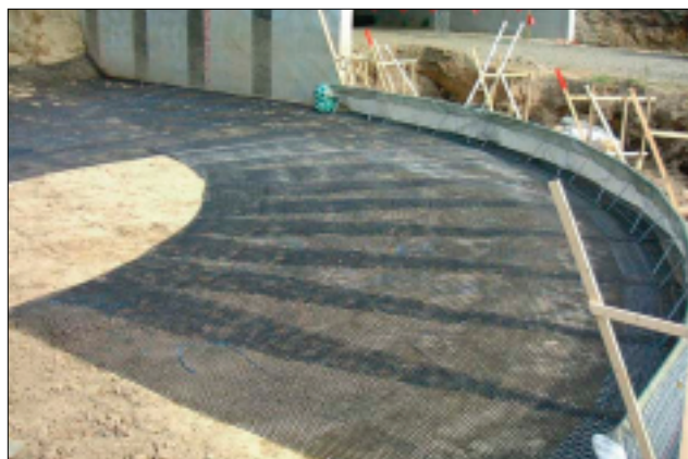
曲線部敷設例
