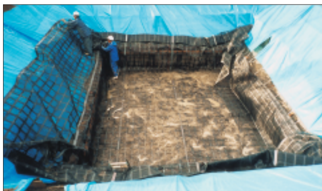
防火水槽下部マットレス工
