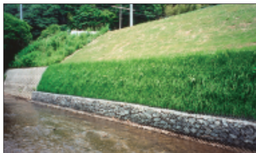
補強土護岸工
