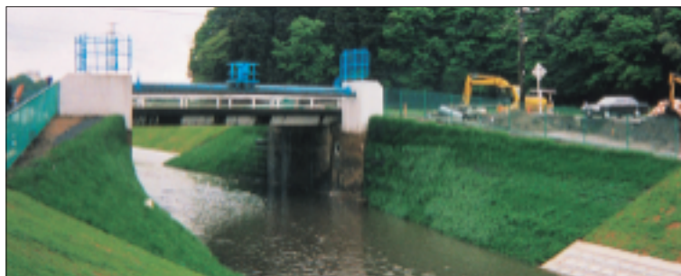
橋台すり付け部補強土壁工
