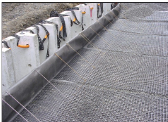
アデム®の敷設
