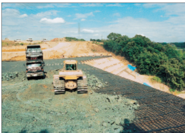
敷地造成盛土工
