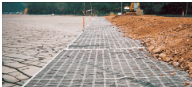
埠頭用地造成工事
