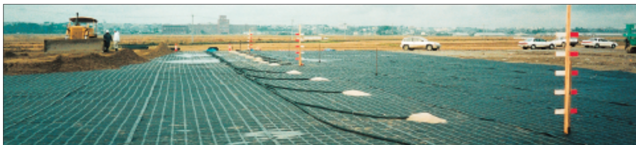
国道バイパス工事
