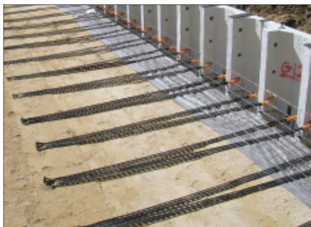
壁面固定ベルト「グリッドベルト」の設置
