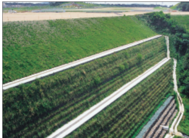
宅地造盛土工
