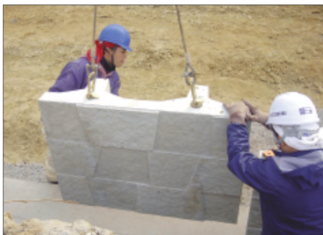
コンクリートパネルの設置
