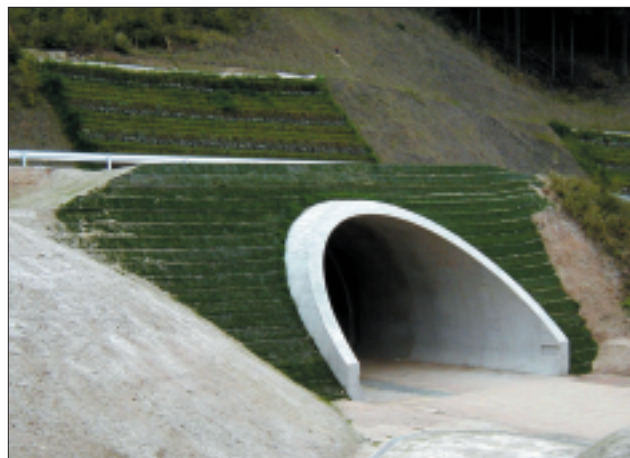
トンネル坑口
