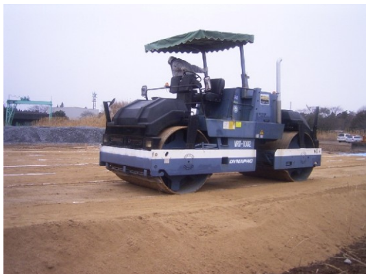
③振動ローラによる転圧
